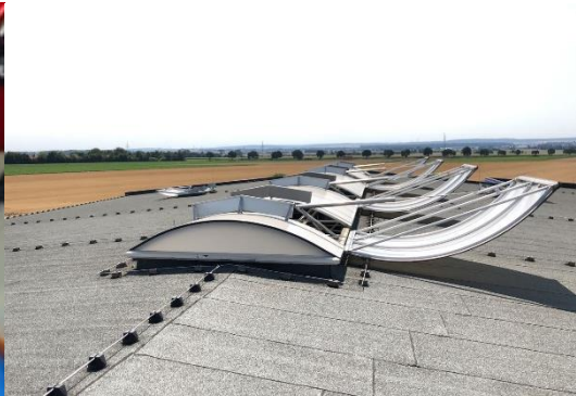
Rauchwärmeabzugsanlage
